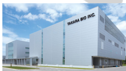
タカラバイオ本社（滋賀県草津市）
