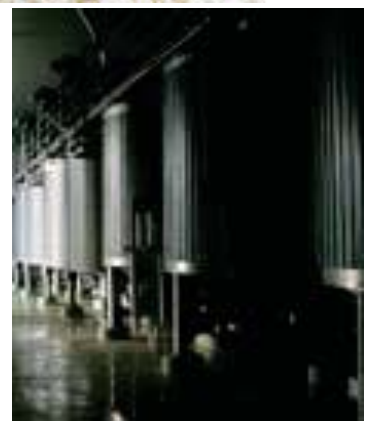
仕込みタンク
