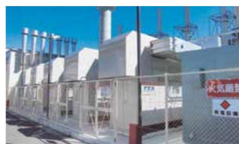
マイクロガスタービン コージェネレーションシステム
