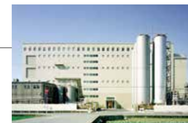
伏見工場 (東)京都府京都市伏見区竹中町625 (西)京都府京都市伏見区下鳥羽葦田町101
